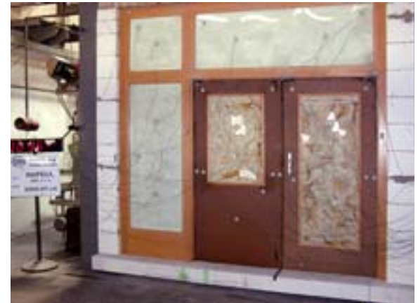
zkouška požární odolnosti - 35:21 min. (norma vyžaduje odolnost 30 min.)
