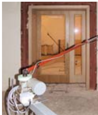
zkouška zvukové izolačních vlastností - dvoukřídlé prosklené dveře
